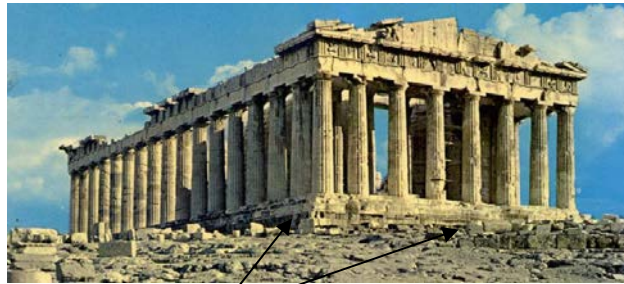
θεμέλιος τοίχος κίωνων ύψους 11 μέτρων
