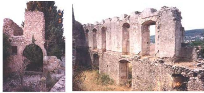
Σχ. 4 Τα λίθινα τοξωτά υπέρθυρα συμπεριφέρονται πολύ καλά στη συμμετρική κατακόρυφη φόρτιση γενικά, και επομένως έναντι του κατακόρυφου σεισμικού κραδασμού. Σεισμός Κεφαλονιάς, 1953. Τα τοξωτά υπέρθυρα αντέχουν μέχρι σήμερα
