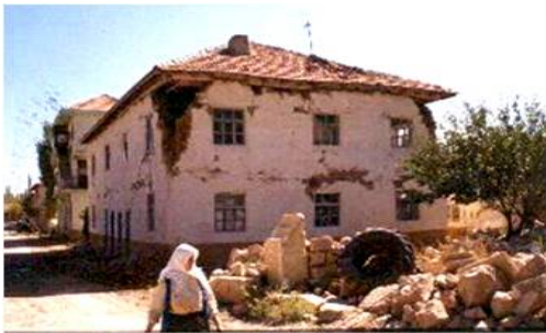
Σχ. 3 Κλασικές συμμετρικές ζημιές περί κατακόρυφο άξονα, οριζόντιες και όχι χιαστί ρωγμές στο πρώτο και δεύτερο επίπεδο. Σεισμός Dinar, Turkey 1995
