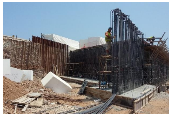
Σχ. 3 - Αντικατάσταση επιχώματος πίσω από τα ακρόβαθρα με ελαφρύ επίχωμα EPS. Η κατασκευή πραγματοποιείται ανεξάρτητα για κάθε κλάδο με χρήση αντιστήριξης μεταλλικών πασσαλοσανίδων
