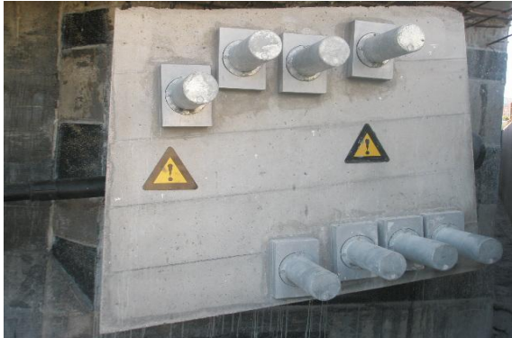
Σχ. 1 - Στοιχείο αγκύρωσης εξωτερικής προέντασης μέσω τριβής. Οι θέσεις διάτρησης οπών για την διέλευση των εγκάρσιων προεντεταμένων ράβδων καθορίστηκαν από επιτόπου μαγνητικές μετρήσεις.
