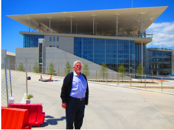
Εικόνα 1. Η αναρτημένη στέγη μετά την αποπεράτωσή της
