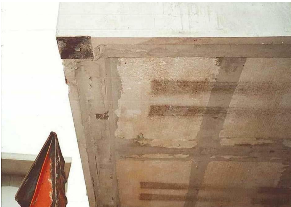
Εικ. 2: Οπή διέλευσης του συρματόσχοινου της προέντασης και οι προεξοχές του σκυροδέματος για την παρεμπόδιση οριζόντιων μετακινήσεων κατά τις 2 διευθύνσεις.
