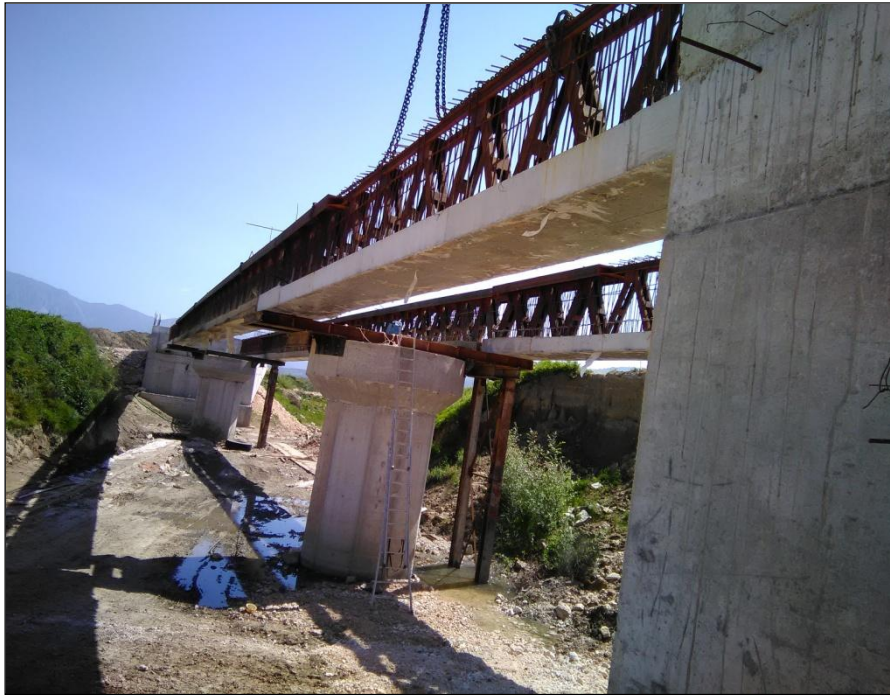
Εικ.1 Τοποθέτηση δοκών «τοξου του Οδυσσέα» στα βάθρα της γέφυρας.
