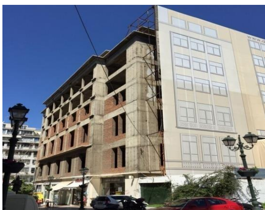
Σχ.1 Εξωτερική φωτογραφική λήψη του κτιρίου
