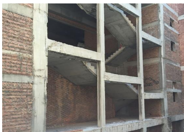
Σχ. 2 Εσωτερική φωτογραφική λήψη του κτιρίου
