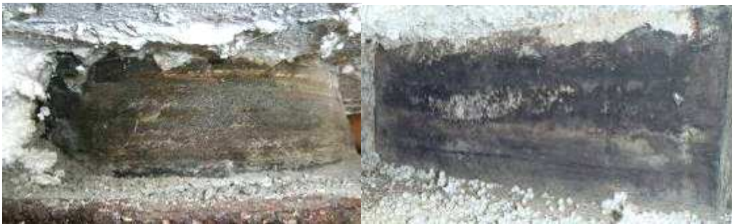
Σχ. 7, 8. Εκτεταμένος αποχρωματισμός εφεδράνων
