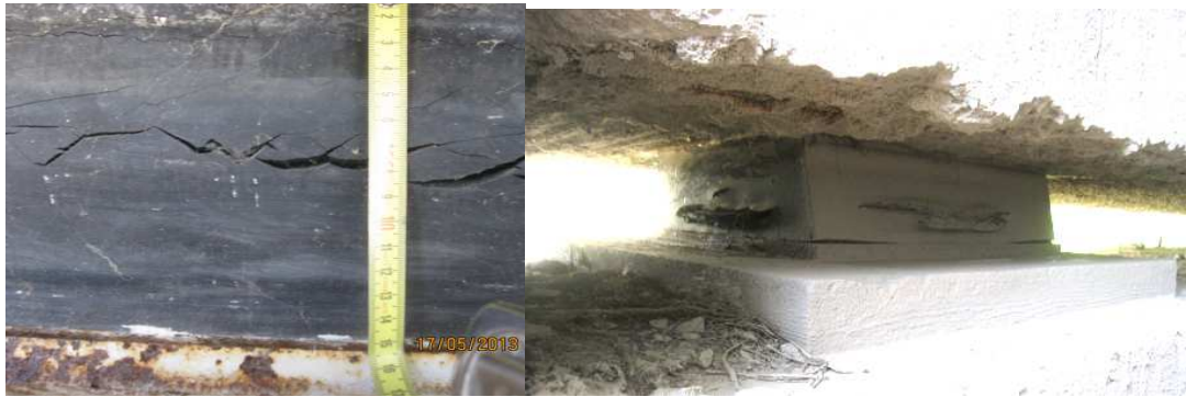
Σχ. 9, 10. Περιμετρικά σκισίματα ελαστομερούς εφεδράνων
