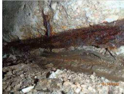
Σχ. 19, 20. Μικρή και μέτρια αντίστοιχα σχετική ολίσθηση μεταξύ διαδοχικών καθ' ύψος στρώσεων ελαστομερούς
