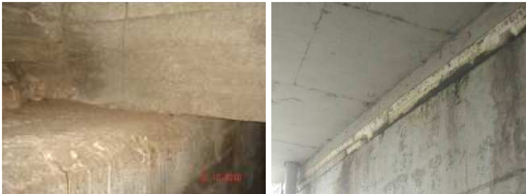
Σχ. 15, 16 . Κάλυψη εφεδράνων από σκυρόδεμα/ πολυστερίνη
