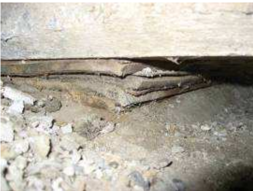
Σχ. 21, 22. Μεγάλη σχετική ολίσθηση μεταξύ διαδοχικών καθ' ύψος στρώσεων ελαστομερούς με πλήρη δομική αποδιοργάνωση του εφεδρανου
