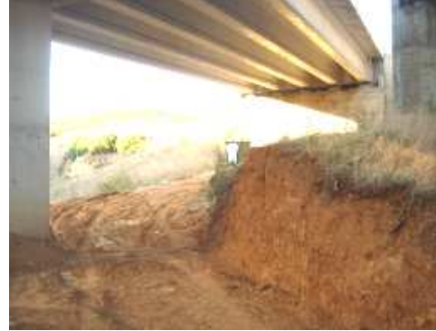
Σχ. 1 Επιθεώρηση με τηλεσκοπικό καλάθοφόρο γερανό Σχ. 2 Διάνοιξη οδού προσπέλασης
