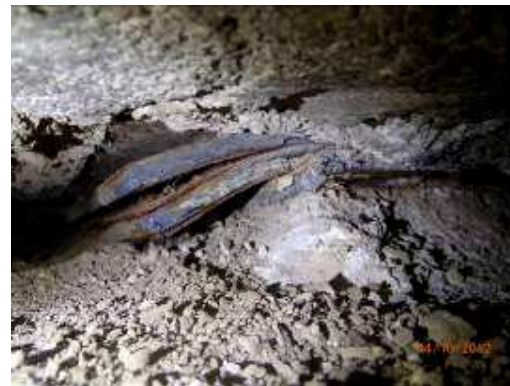
Σχ. 21, 22. Μεγάλη σχετική ολίσθηση μεταξύ διαδοχικών καθ' ύψος στρώσεων ελαστομερούς με πλήρη δομική αποδιοργάνωση του εφεδρανου
