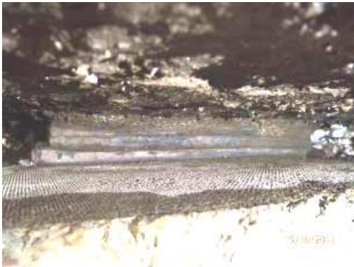
Σχ. 19, 20. Μικρή και μέτρια αντίστοιχα σχετική ολίσθηση μεταξύ διαδοχικών καθ' ύψος στρώσεων ελαστομερούς
