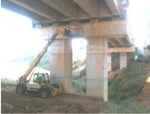
Σχ. 1 Επιθεώρηση με τηλεσκοπικό καλάθοφόρο γερανό Σχ. 2 Διάνοιξη οδού προσπέλασης
