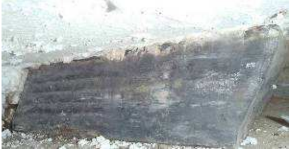
Σχ. 17, 18 . Μεγάλες διαμήκειες πλευρικές αποκλίσεις εφεδράνων
