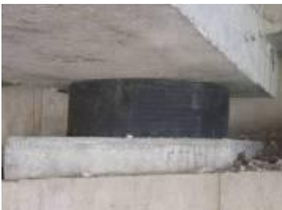
Σχ. 1 Εφεδράνο σε καλή κατάσταση
