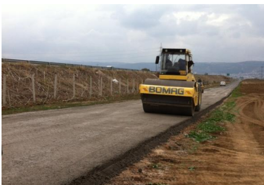
Σχ. 5 Συμπύκνωση οδοστρώματος με οδοστρωτήρα
