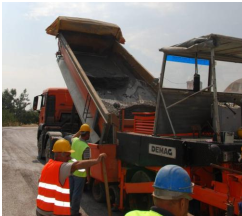
Σχ. 3 Το νωπό σκυρόδεμα έχει κολλήσει στο φορτηγό λόγω καθυστέρησης στη μεταφορά
