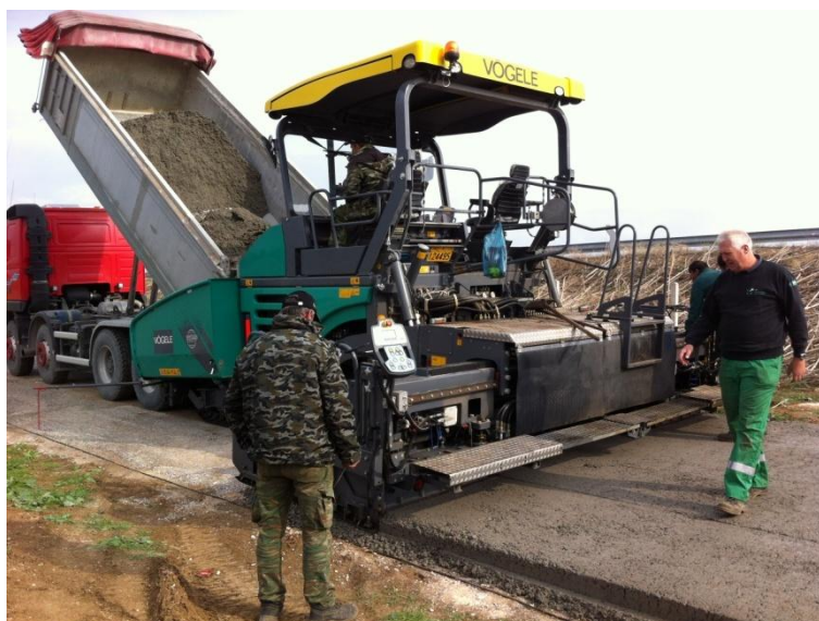
Σχ. 2 Τροφοδοσία του σκυροδέματος από το φορτηγό στον διαστρωτήρα (paver) και διάστρωση του δρόμου
