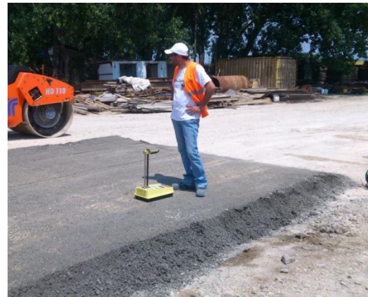
Σχ. 4 Μέτρηση της πυκνότητας του νωπού σκυροδέματος με το Humbolt
