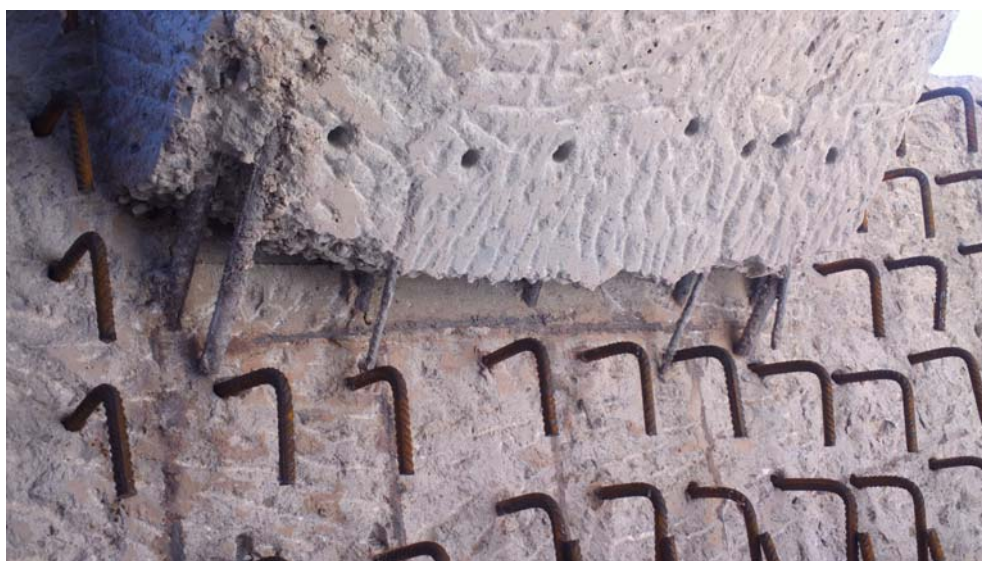
Σχ. 12 Προετοιμασία πέδινων για σκυροδέτηση του επιπλέον πάχους τους (τοποθέτηση οπλισμού σύνδεσης υφιστάμενου με νέο σκυρόδεμα).
