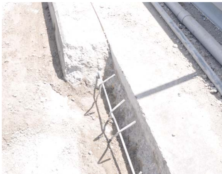
Σχ. 15 Καθαίρεση τμήματος του υφιστάμενου πεζοδρομίου για ενσωμάτωση σε αυτό καναλιού συλλογής όμβριων.
