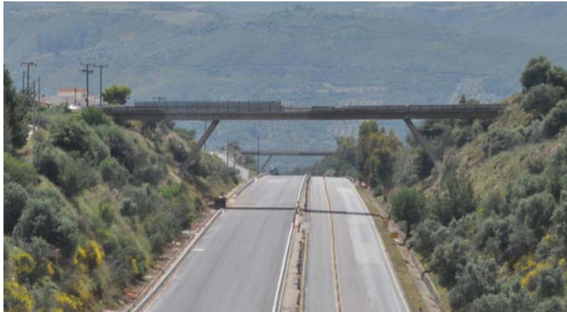
Σχ. 2 Γενική άποψη της Άνω Διάβασης Α296.
