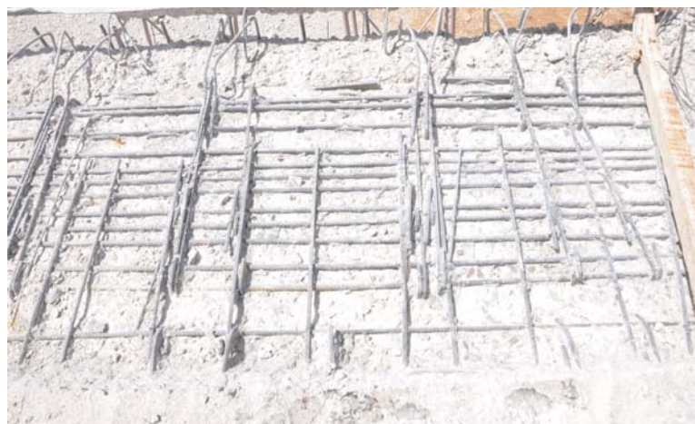
Σχ. 9 Υδροκαθαίρεση σκυροδέματος στο άνω τμήμα των διαδοκίδων.
