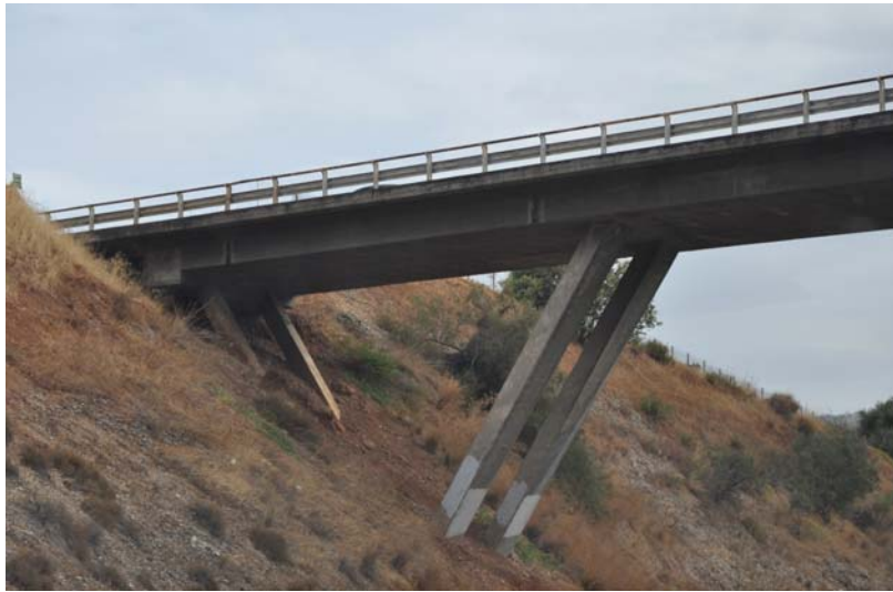
Σχ. 2 Αποψη μεσοβάθρου Μ1 Άνω Διάβασης Α296.
