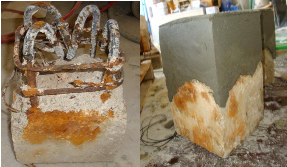
Σχήμα 1: Δοκίμιο οπλισμένου σκυροδέματος α) μετά την ολοκλήρωση της πρώτης φάσης διάβρωσης (αριστερά) και β) μετά την επισκευή του (δεξιά).
