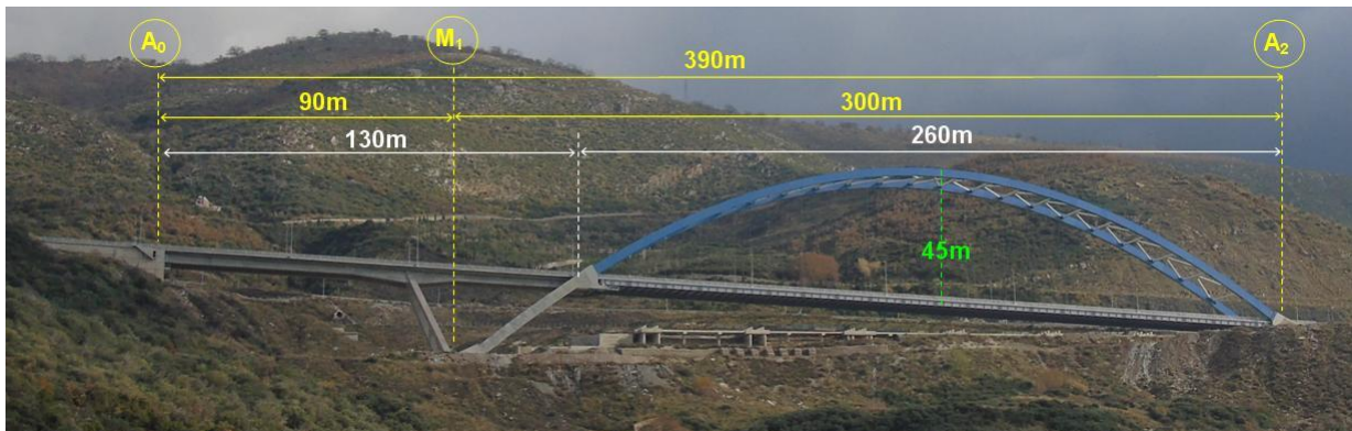
Φωτογραφία. 1: Διαμήκης όψη της γέφυρας
