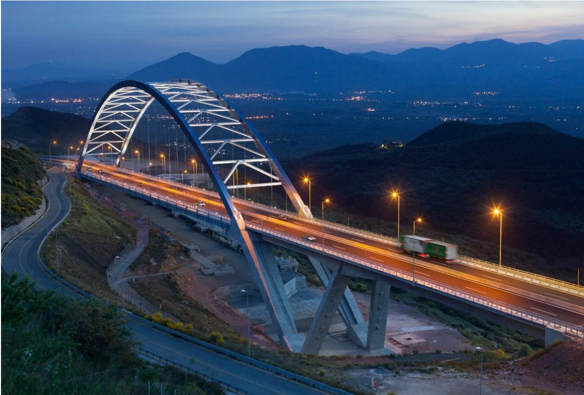
Φωτογραφία. 2: Η γέφυρα σε λειτουργία
