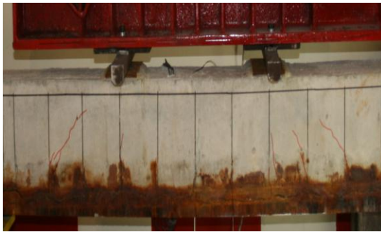
Σχ. 8 Μοτίβο ρηγματώσεων δοκού BC1 στο τελευταίο επίπεδο διάβρωσης.
