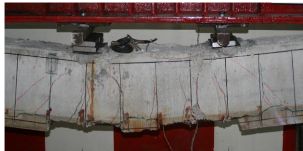
Σχ. 5 Αποκόλληση τμήματος σκυροδέματος στο μεσαίο άνοιγμα της δοκού BC κατά τη φόρτιση.
