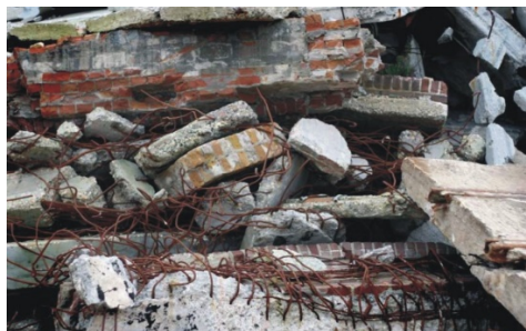
Εικόνα 3: Ογκώδη Τεμάχια Αποβλήτων που προέκυψαν από καθαίρεση κτιρίου
