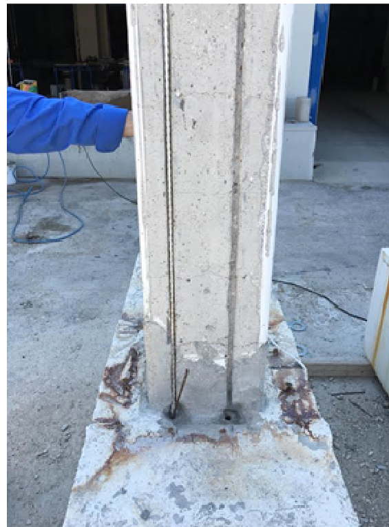
Σχ. 2 Προετοιμασία δοκιμίου για τοποθέτηση NSM
