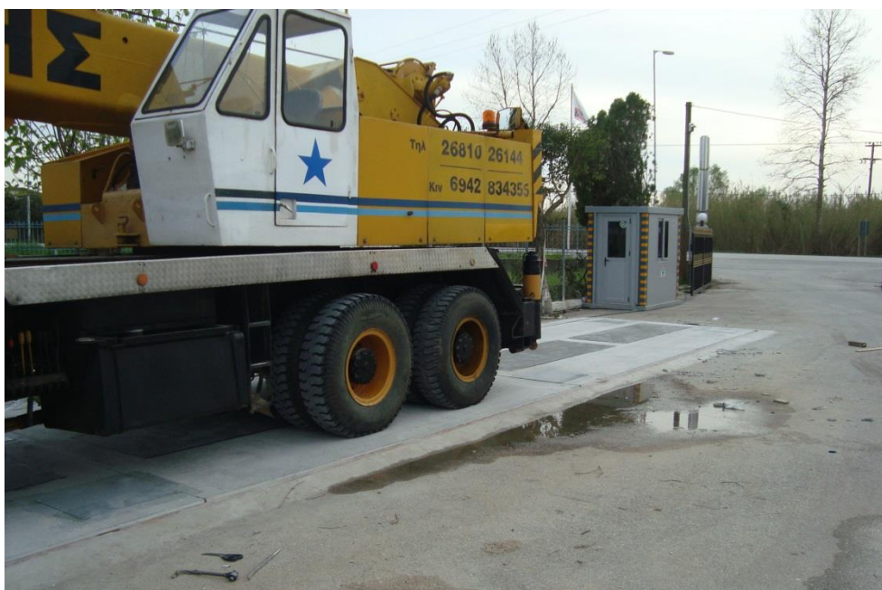
Εικ. 1: Γεφυροπλάστιγγα διαστάσεων 3.00x18.00m.
