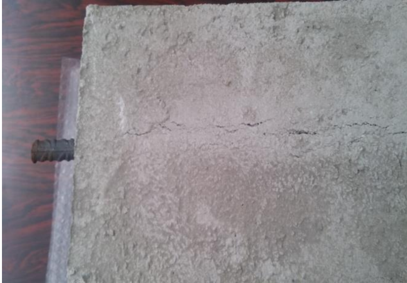
Σχήμα 2. Η λόγω διάβρωσης επιφανειακή ρηγμάτωση στο σκυρόδεμα (δοκίμιο δίχως συνδετήρες).
