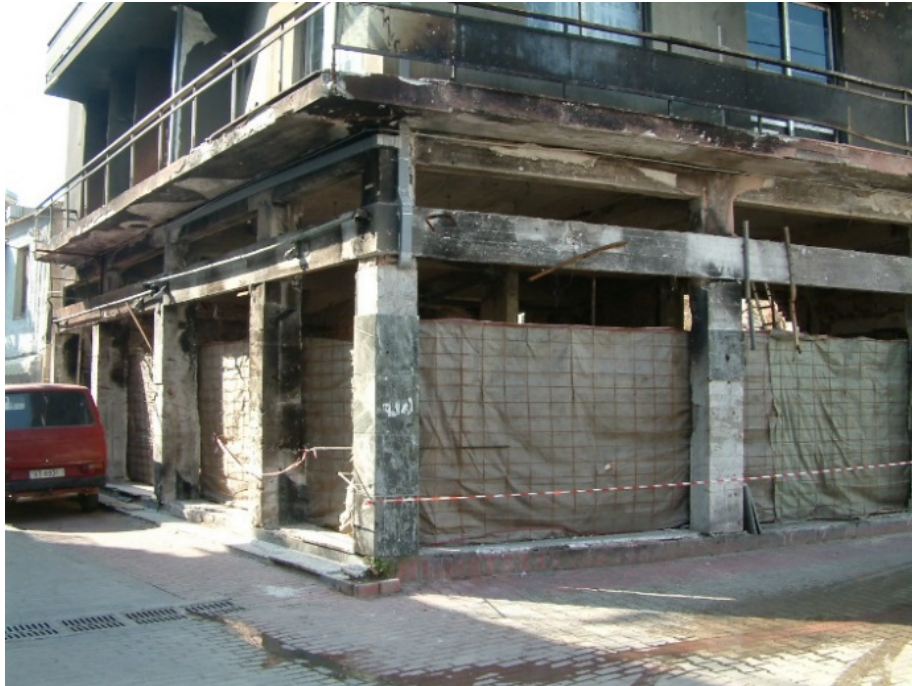
Σχήμα 1. Ισόγειο της κατασκευής που εκτέθηκε σε πυρκαγιά.
