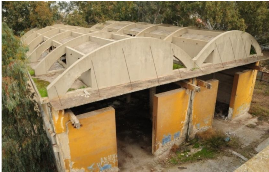
Σχήμα 1: Υφιστάμενη Κατάσταση του Κτιρίου Ιρις 1
