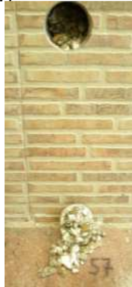
Σχήμα 2. (α) Εκτέλεση πυρηνοληψίας. (β) Καπέλωμα και εύρεση θλιπτικής αντοχής πυρήνων. (γ) Απομείξεις σκυροδέματος και σκυροφωλιές σε Πλ.1'/εσ. Υπ. Κ16
