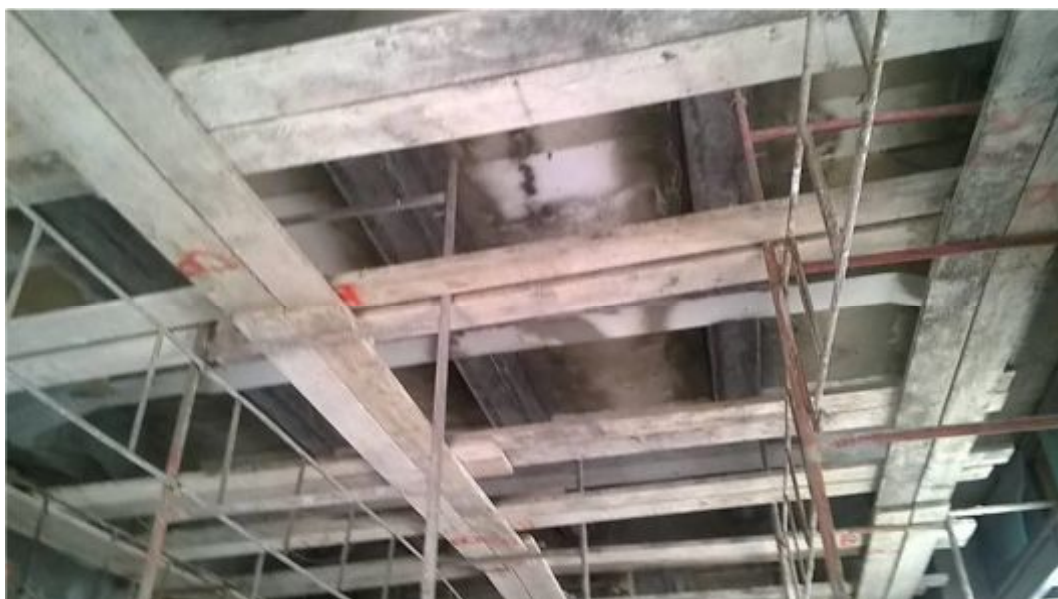
Σχήμα 10: Δοκοί/ Μανδύας εκτοξευόμενου σκυροδέματος
