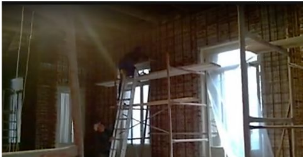
Σχήμα 5: Τοποθέτηση δομικού πλέγματος T139 και διαμήκους οπλισμού περιμετρικής τοιχοποιίας
