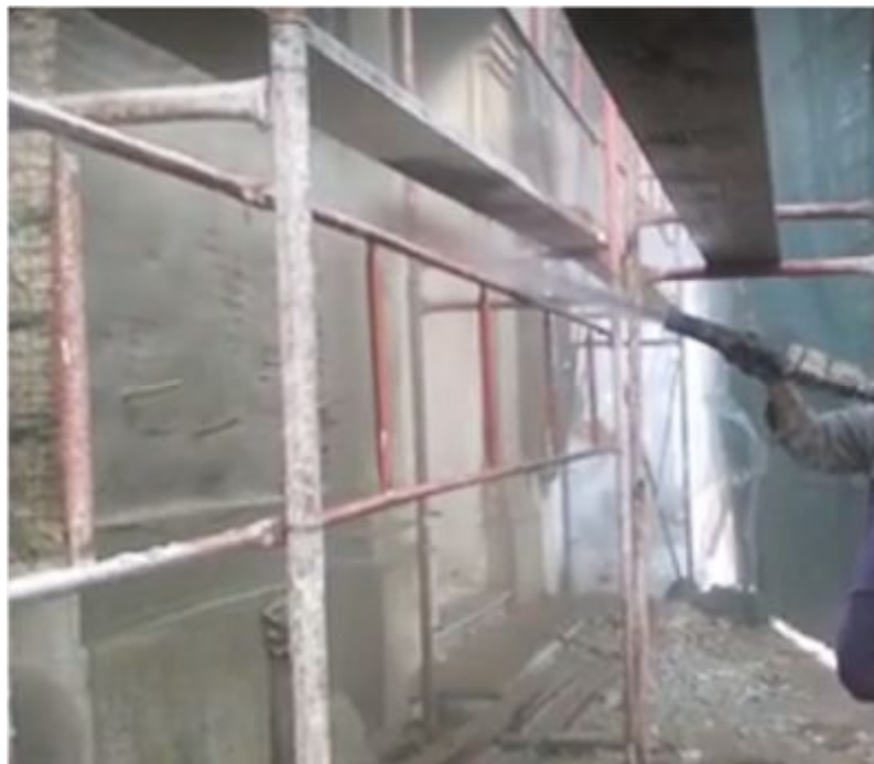
Σχήμα 6: Κατασκευή μανδύα από εκτοξευόμενο σκυρόδεμα στην τοιχοποιία
