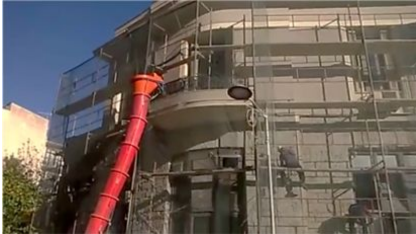
Σχήμα 3: Εξωτερική όψη οικίας Παπαθεοδώρου κατά την περίοδο των εργασιών (Οκτώβριος 2016)
