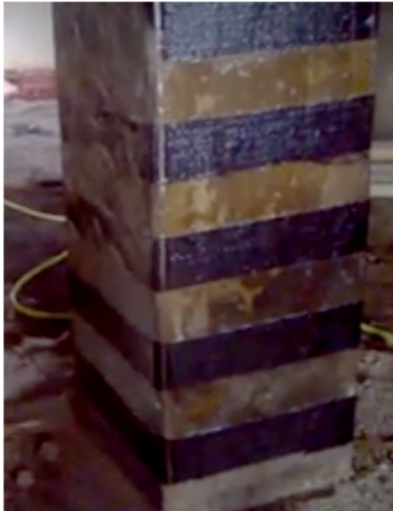
Σχήμα 8: Περίσφιξη υποστυλώματος με ανθρακοϋφασμα και επί της νωπής στρώσης σφράγιση ακολούθησε επίταση, για τη δημιουργία βαθμού αδρότητας, αποσκοπώντας στην εξασφάλιση υψηλής συνάφειας
