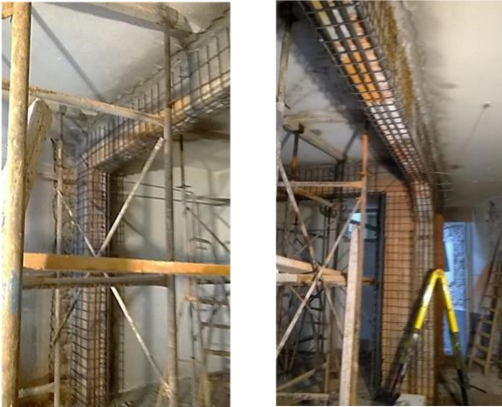
Σχήμα 9: Τοποθέτηση διαμήκους και εγκάρσιου οπλισμού
