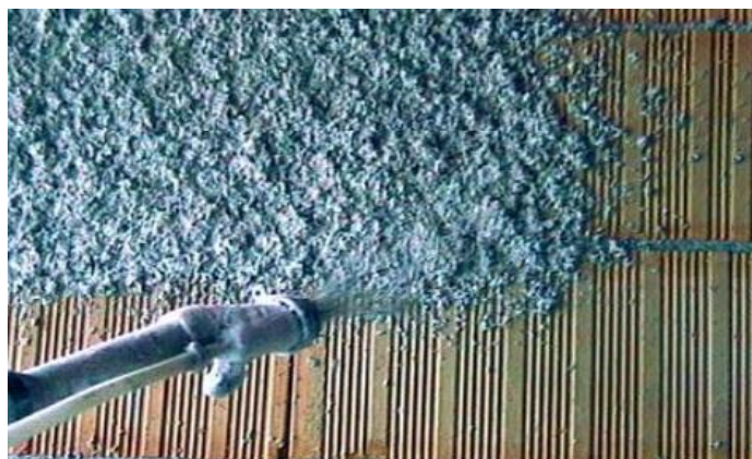
Τυπική Εφαρμογή Θερμομονωτικού Κονιάματος
