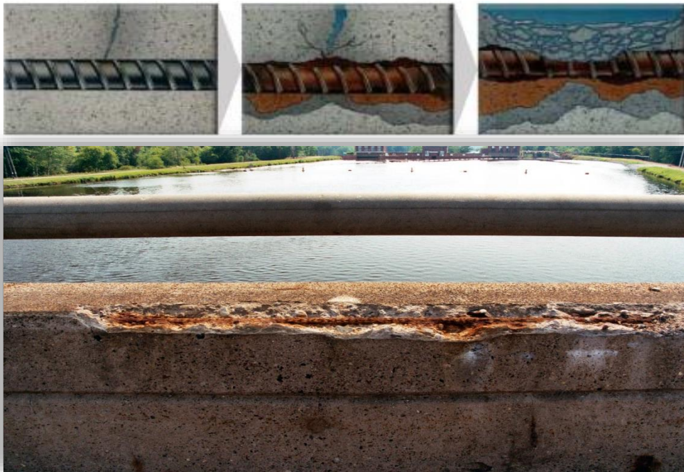
Σχήμα 3: Διάβρωση Οπλισμού
