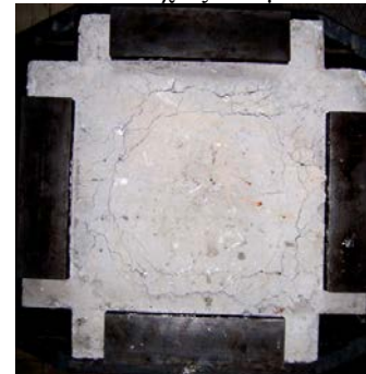
Εικόνα αστοχίας δοκιμίου Δ-4
