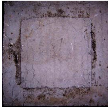
Εικόνα αστοχίας δοκιμίου Δ-9
