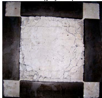
Εικόνα αστοχίας δοκιμίου Δ-5
