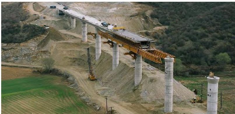
Σχήμα 5. Κατασκευή γέφυρας με τη μέθοδο Αυτοφερόμενου Προωθούμενου Μεταλλότυπου
