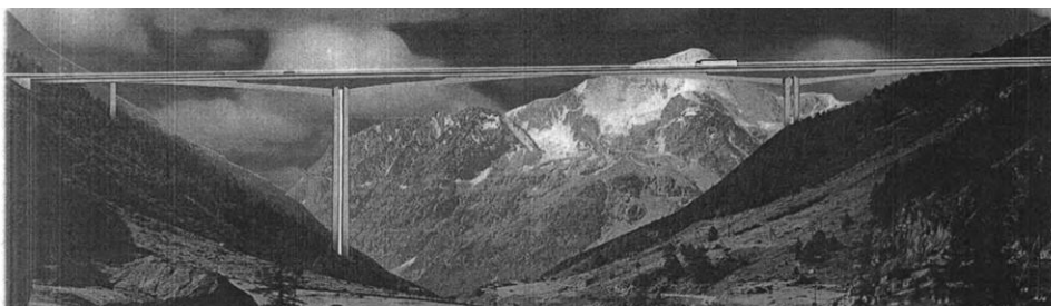
Σχήμα 4. Εφαρμογή της Προβολοδόμησης στη γέφυρα Μετσοβίτικου της Εγνατίας
