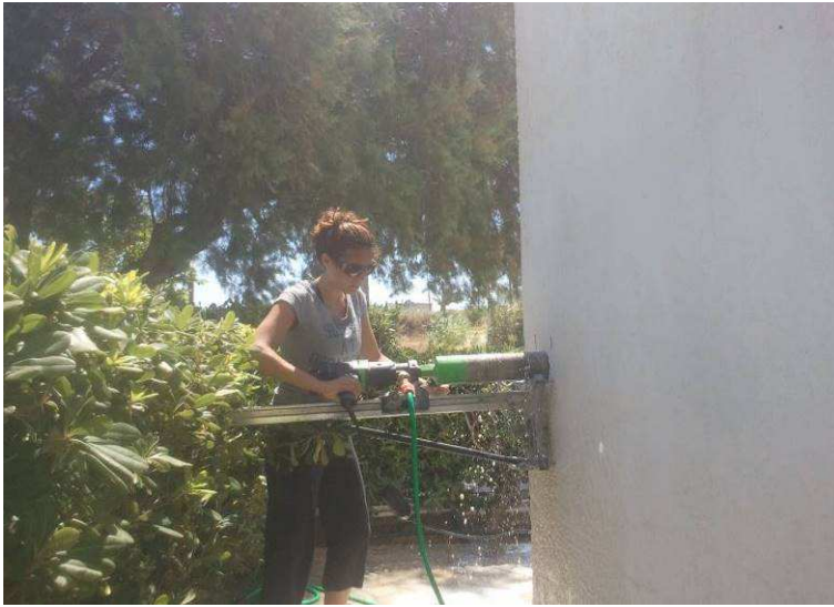
Σχήμα 1: Λήψη κυλινδρικού δοκιμίου σκυροδέματος από τοίχιο.
