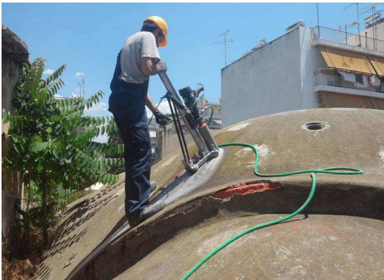
Σχήμα 2: Λήψη κυλινδρικού δοκιμίου σκυροδέματος από θολωτή πλάκα.
