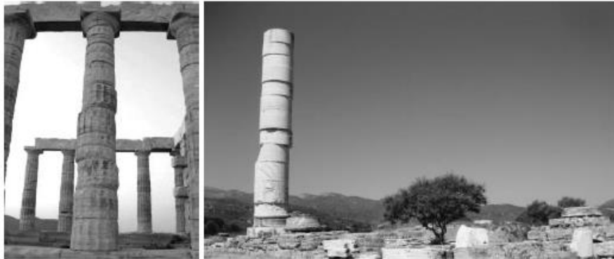
Σχήμα 12: Σχετικές μετατοπίσεις των σπονδύλων κίωνων; Αριστερά ναός του Ποσειδώνα, δεξιά Ηραίο (Σάμος).
