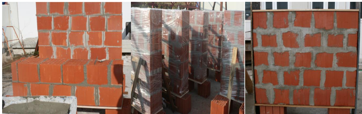
Σχήμα 2: α) Φάση κατασκευής ΑΦΤ, β) συντήρηση 28 ημερών, γ) προετοιμασία καλουπιού και εξωτερικής επιφάνειας για την εφαρμογή της ενίσχυσης TRM
